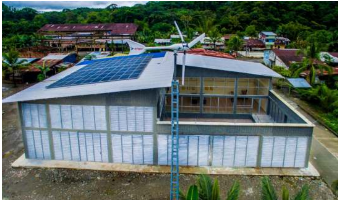
Figura 4. Laboratorio de Energías Renovables, Municipio del Medio San Juan.
